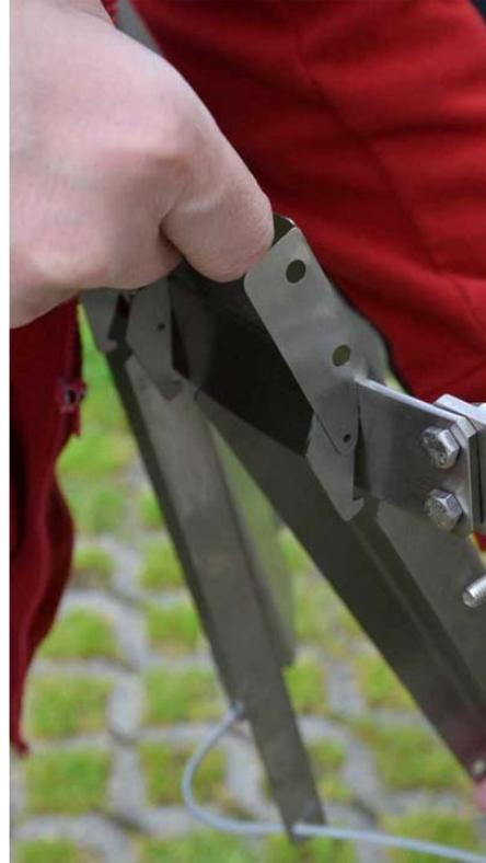
12. Ein Windschutzblech ist mit einem Schnellverschlussystem für das später einzuziehende Stahlseil ausgestattet. Montieren Sie dieses Windschutzblech direkt rechts neben dem Zugangssegment.
