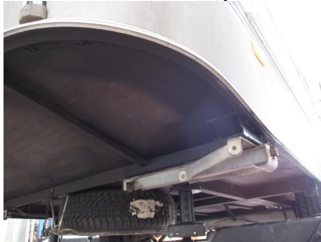
Wohnwagenboden: Hier massive Spanplatte, spärlich geschützt
